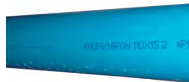
Estado de tubería niron con condensación superficial.
