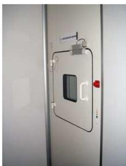
Construidos a medida, con doble puerta estanca por junta estática o neumática y enclavamiento, preparados para desinfección por germicidas o VHP, con sistema de aireación mediante aire ultra filtrado y sistema de control diseñado a medida del usuario.
