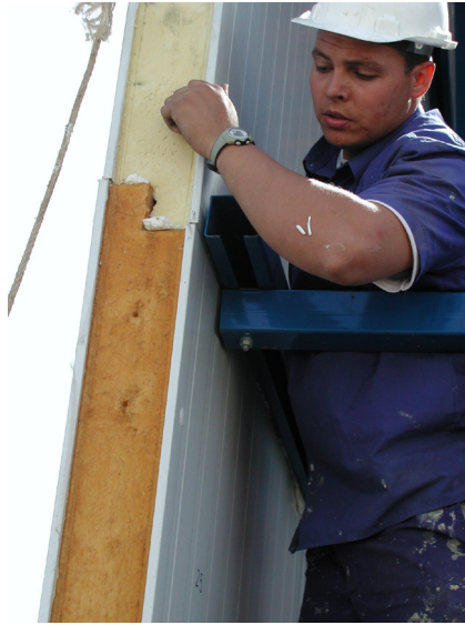
Figura 12. Montaje y fijación de paneles sándwich (Fuente: IPUR)
