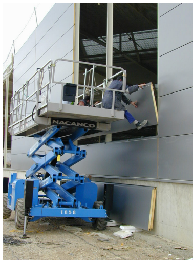
Figura 21 Instalación de paneles sándwich en posición horizontal (Fuente: IPUR)
