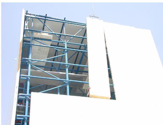
Figura 11. Montaje de paneles sándwich (Fuente: IPUR)
