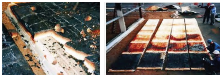
Figura 20. Ejemplo de carbonización de la capa superficial de un panel (Fuente: IPUR)
