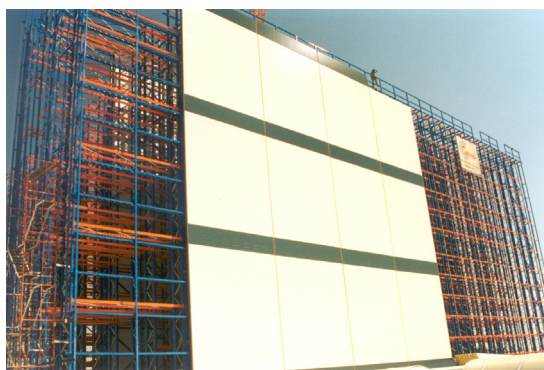
Figura 10. Montaje de paneles sándwich (Fuente: IPUR)
