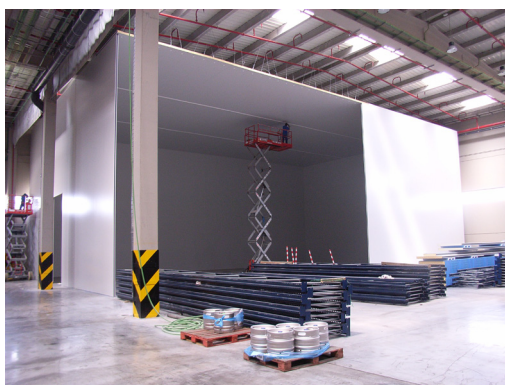
Figura 23. Instalación de paneles sándwich en el interior de la nave (Fuente: IPUR)
