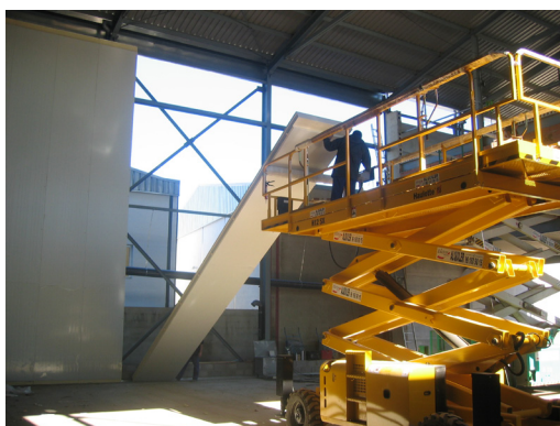
Figura 22. Instalación de paneles sándwich en posición vertical (Fuente: IPUR)
