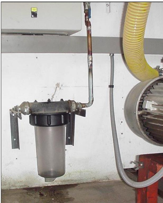
**Fig. 36-“Pot a niveau visible” de una central de 3x250 m3/h de 1985 (aproximadamente) en Barcelona**
