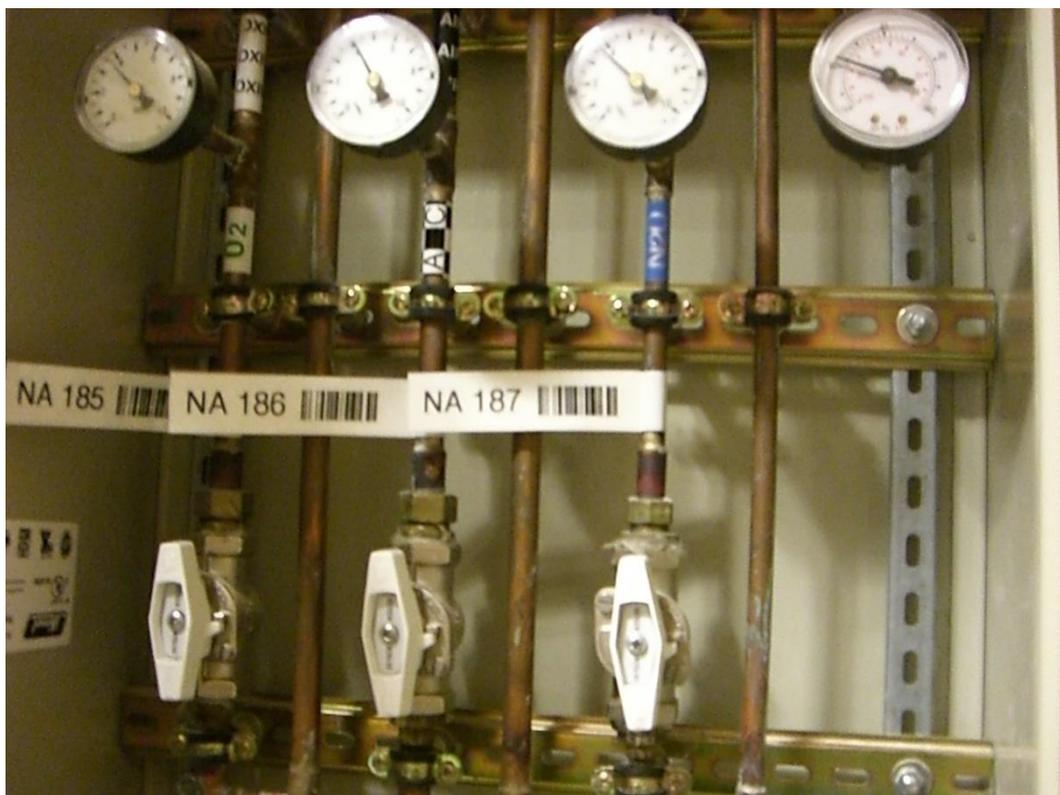
**Fig. 45-Interior de una caja de cierre y control, con identificación de gases y válvulas- Las válvulas con identificación numérica, por código de barras y nombre del gas en la tubería.**
