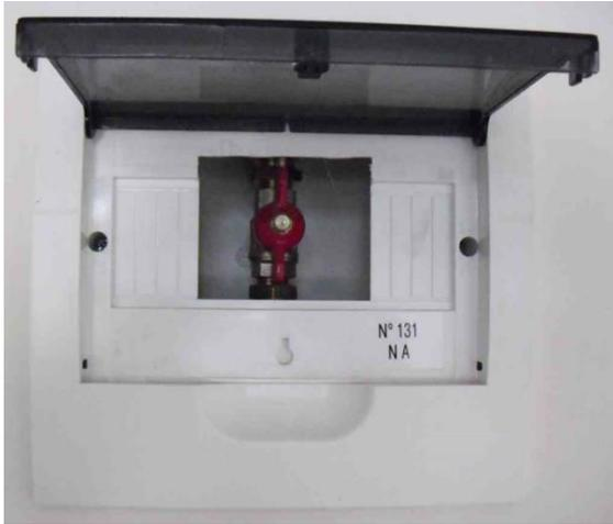
**Fig. 50- Ejemplo de válvula de corte en habitaciones psiquiátricas**
