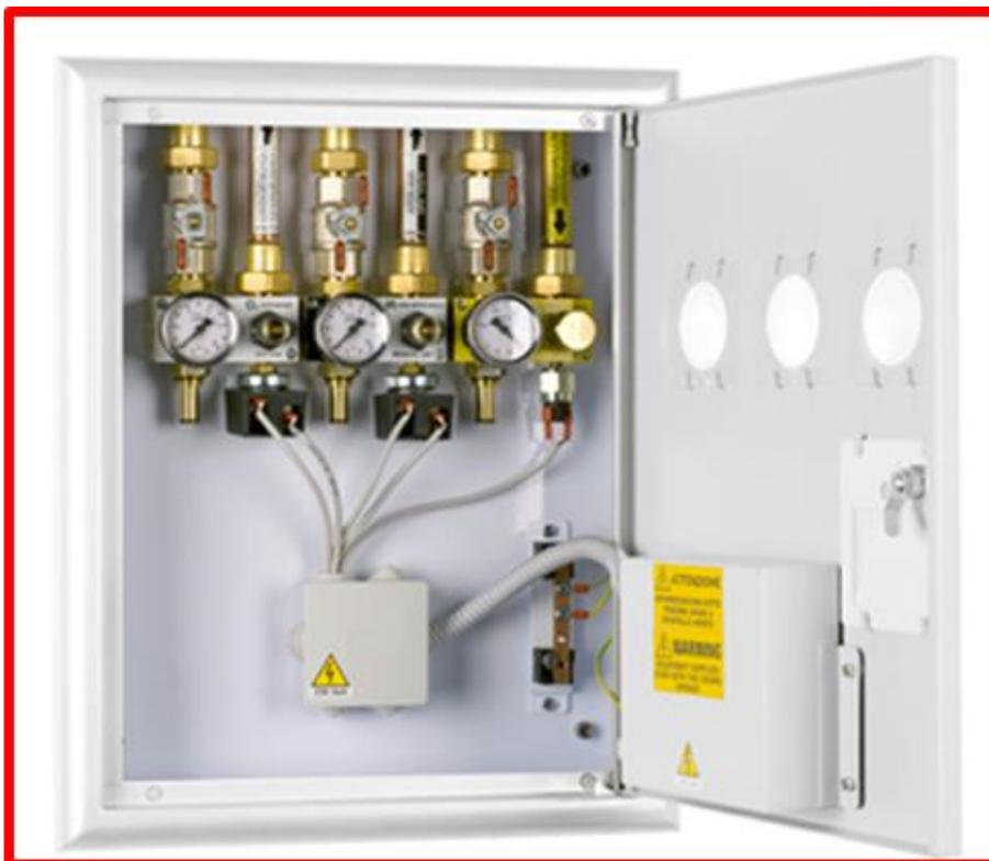
**Fig. 6- Caja de cierre precableada eléctrica y neumáticamente con entradas NIST y elementos de aislamiento de la red**
