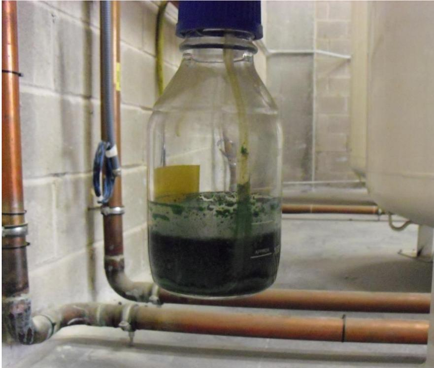
**Fig. 35-Frasco (esterilizable) de drenaje de un filtro**
