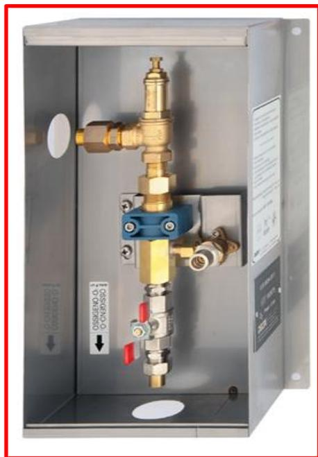
**Fig. 7-Entrada de emergencia en caja separada**
