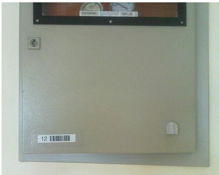
**Fig. 44- Identificación exterior de una caja de cierre y control (instalada aprox. 1977 y señalizada años más tarde). Existe una segunda identificación igual en el interior, que está más resguardada**
