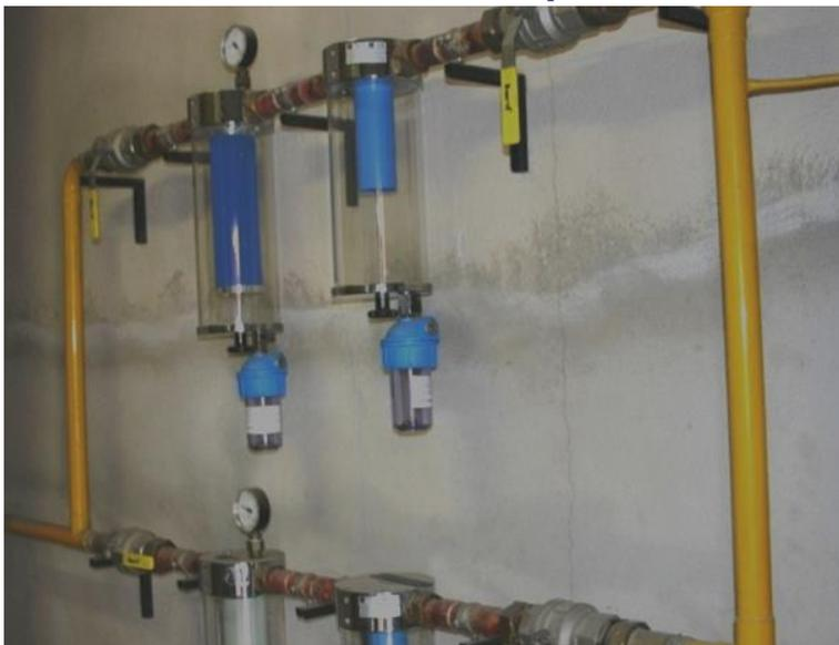
**Fig. 14- Esquema simplificado, con solo 4 válvulas en lugar de 10**
