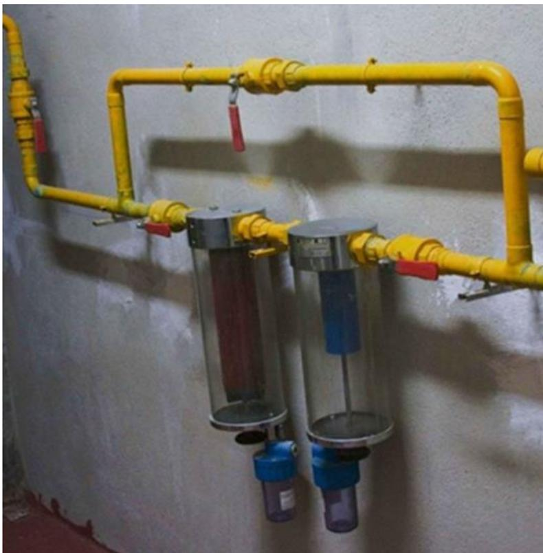
**Fig. 15- Conjunto simplificado, con solo 4 válvulas y un conjunto de filtro y decantador**
