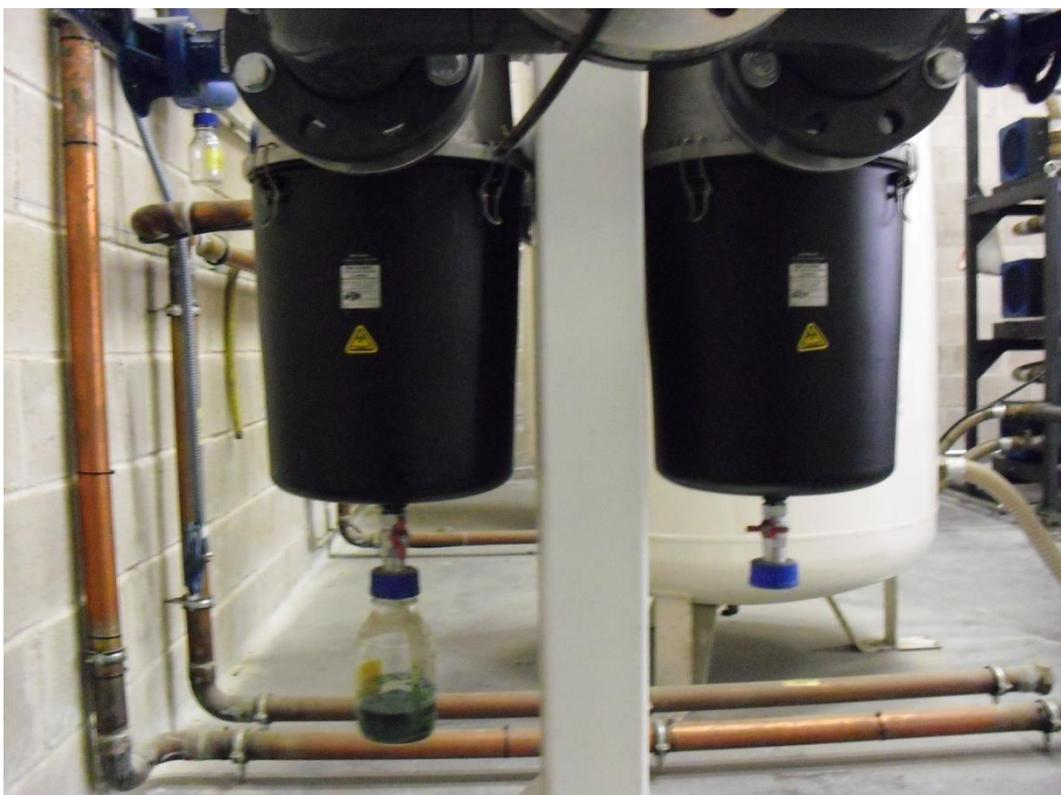
**Fig. 30-Vaso de drenaje esterilizable debajo de un filtro bacteriológico. A lo que se ve queda demostrada su utilidad**
