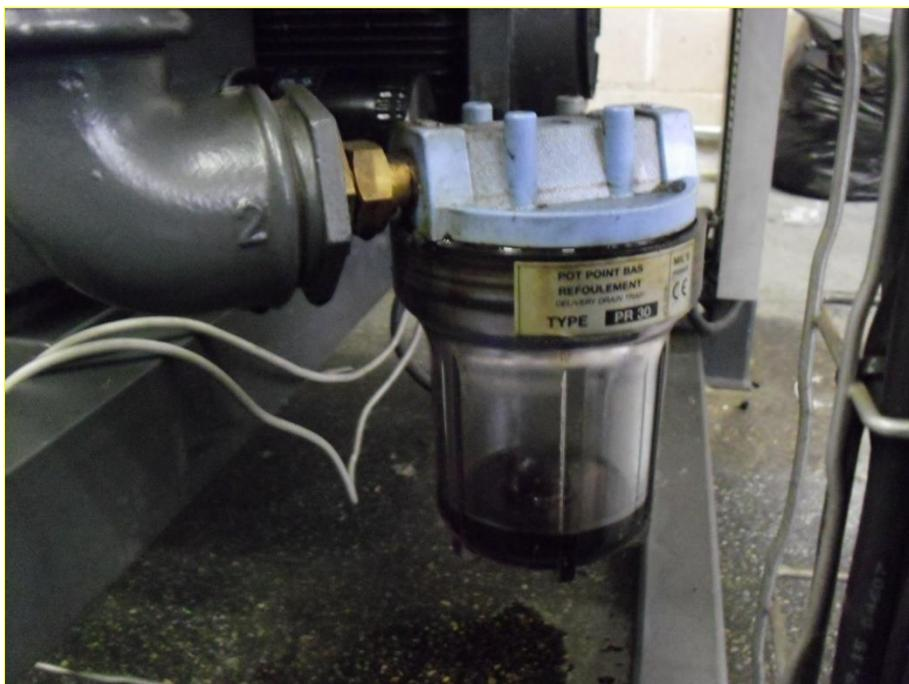
**Fig. 33-“Pot point bas refoulement” (que puede traducirse por frasco en punto bajo en la expulsión) de una central de vacío**
