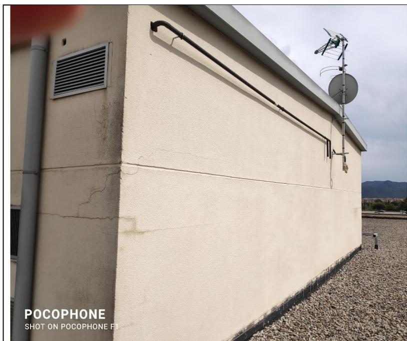
**Fig. 34- Parte exterior de la central de vacío de la Fig. 40; línea de expulsión con doble pendiente (interior y exterior) para evitar en lo posible, tapones de hielo en invierno**
