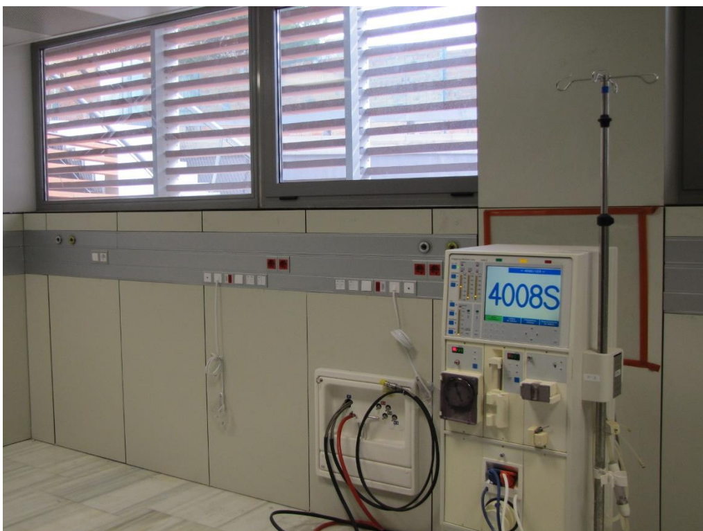
Fig. 26- Aplicación de canal para electricidad y señales (semiempotrada = enrasada)
