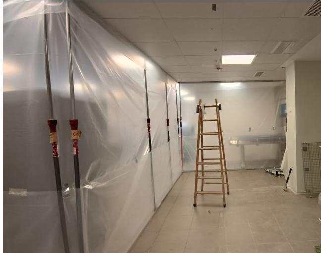
Figura 22. Fotografía interior de la sectorización provisional mediante barrera plástica desde la zona de personal (fuente: fotografía realizada durante visita de obra).
