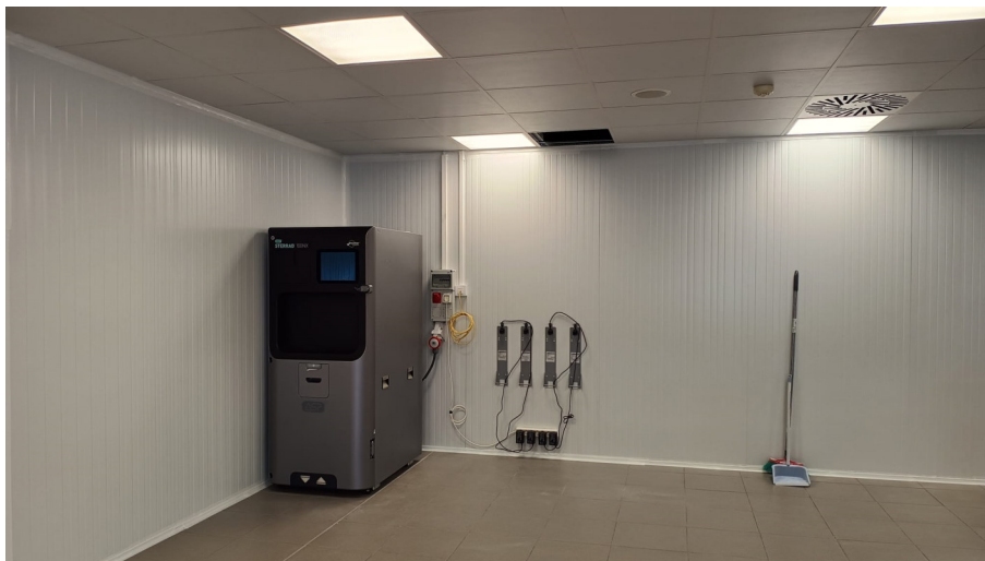
Figura 21. Fotografía interior de la sectorización provisional mediante panel sanitario desde la zona de material limpio (fuente: fotografía realizada durante visita de obra).
